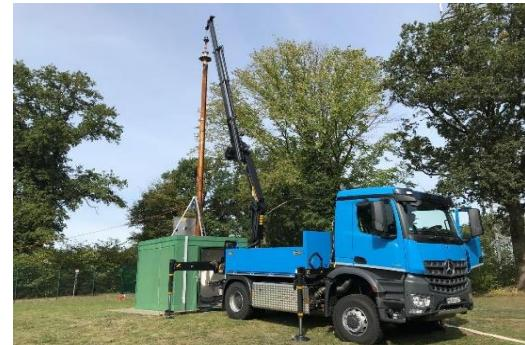
**Anzahl Bohrungen:** **1****Bohrtiefe in m:** **89****Bohrmeter gesamt:** **89****Bohr-Ø in mm:** **DN 400****Ausbaudaten:** **DN 300/250/KV/VA****Zweck der Bohrung:****Sanierung Br. 57 WW Bexhövede mittels Inliner.**
